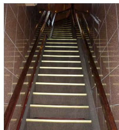
L'étroitesse et la pente des escaliers ne permet pas d'emménager ou de déménager classiquement.
