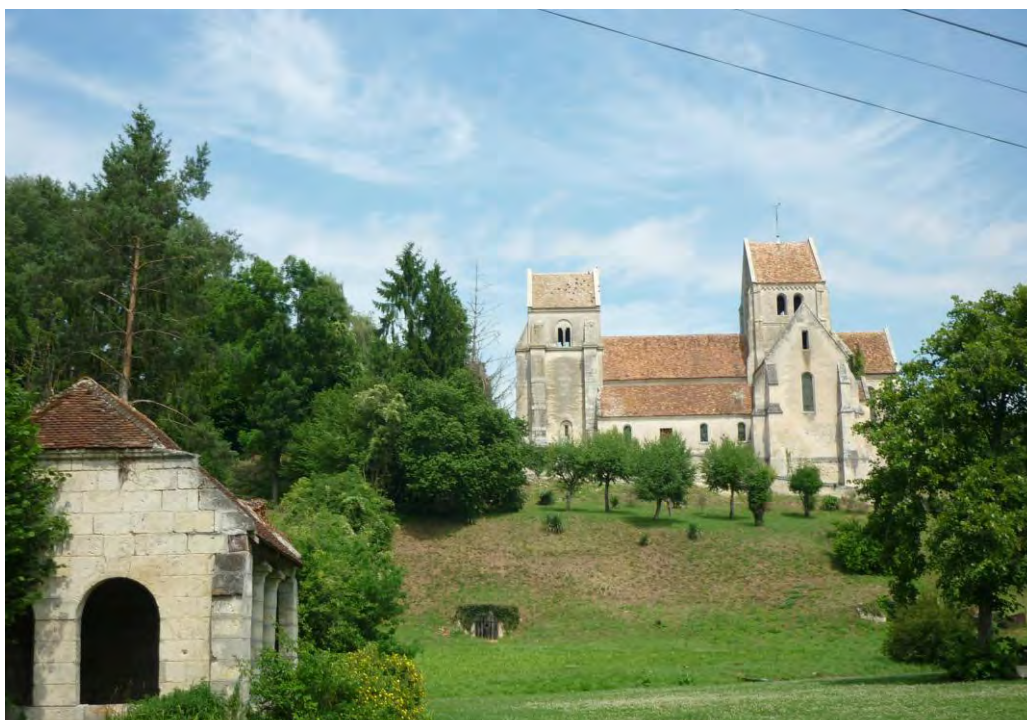
Le lavoir de Septvaux du XIIème siècle avec l'église romane aux 7 pignons et 2 clochers.
