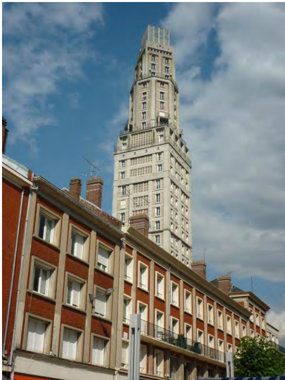
La tour Perret construite en 1950, en béton armé et haute de 110 mètres avec 27 étages d'appartements et de bureaux.
